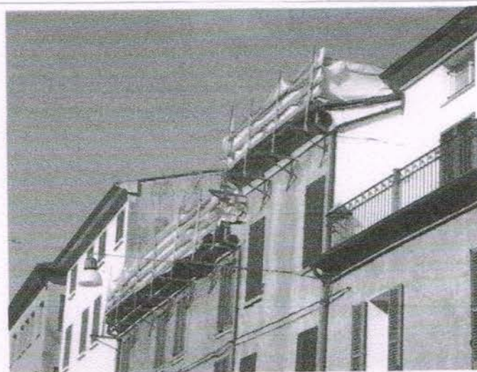
Figura 11 Ponteggio a sbalzo completo di barriere e teli di protezione.
