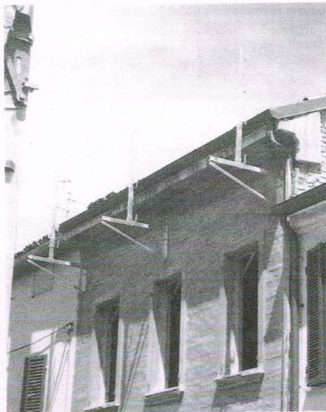
Figura 10 Ponteggio a sbalzo in fase di installazione.
